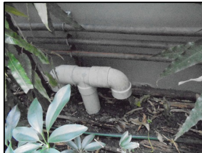
รูปที่ 21 ท่อระบายอากาศจากระบบบำบัดน้ำเสียเพื่อกำจัดละอองเสียด (Aerosol)
