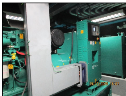
รูปที่ 14 เครื่องจ่ายสำรองไฟ (Generator)
