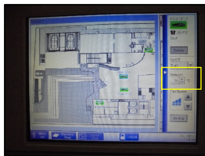
รูปที่ 34 การตั้งอุณหภูมิของระบบปรับอากาศที่ 25 องศาเซลเซียส
