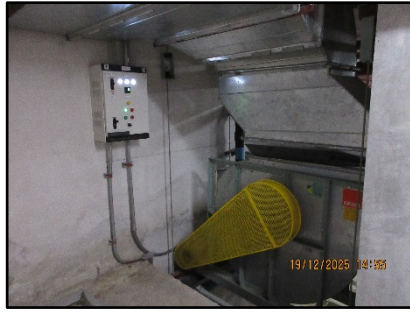
รูปที่ 4 ระบบระบายอากาศในที่จอดรถชั้นใต้ดิน
