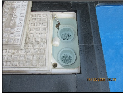
รูปที่ 47 ระบบระบายน้ำล้น
