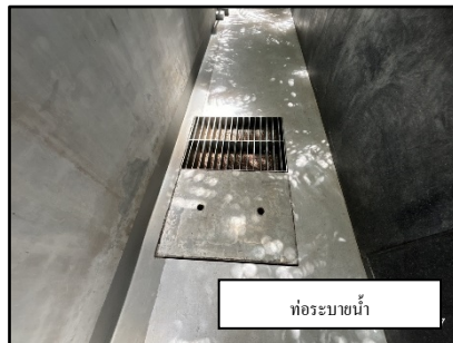
รูปที่ 21 ท่อระบายอากาศจากระบบบำบัดน้ำเสียเพื่อกำจัดละอองเสียด (Aerosol)
