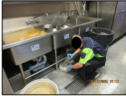
รูปที่ 20 การตัดไขมันในถังดักไขมัน
